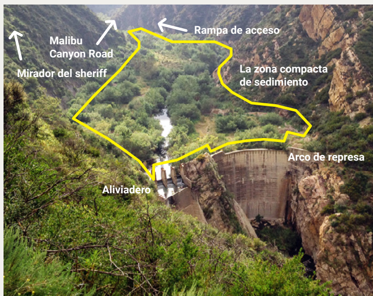
Estructura de la represa Rindge, la zona compacta de sedimento y puntos de referencia clave.
